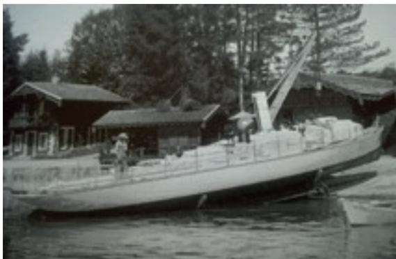
Ce vapeur fut construit pour battre des records de vitesse sur le Léman, sa coque de 23,50 m pour 3,30 m de largeur, lui permit d'atteindre une vitesse de navigation de 41 km/h. Il changea de nom pour devenir le «Deria i Nour» et appartient dès 1930 à M. Kitabgi Kahn. De 1947 à 1960 c'est M. Trémolière qui
